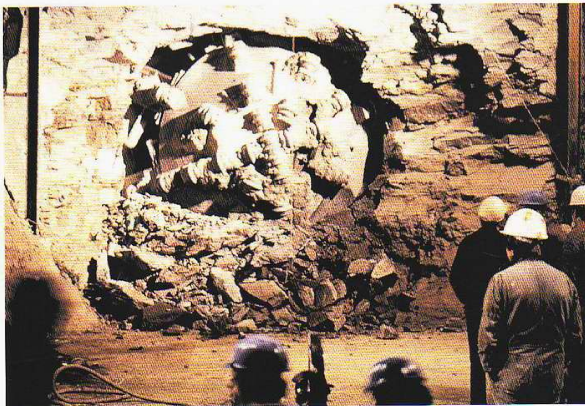
Εικόνα 12.25 Ειδικός «μετροπόντικας» επιστρατεύθηκε για να διανοιχθεί η σήραγγα του επιταχυντή LEP, η οποία τώρα πρόκειται να χρησιμοποιηθεί για τις ανάγκες του LHC, βαθιά κάτω από τα γαλλοελβετικά σύνορα κοντά στη Γενεύη. Ο δακτύλιος των υπεραγωγικών μαγνητών που συγκροτούν τον επιταχυντή LHC είναι εγκατεστημένος μέσα σε αυτή τη σήραγγα.
